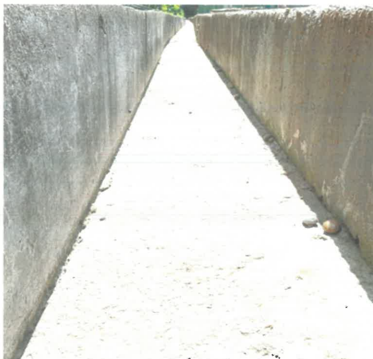
Fig. 11-1 Vedere a rigolei de colectare ape pluviale situată la limita amplasamentului fabricii de PAL
