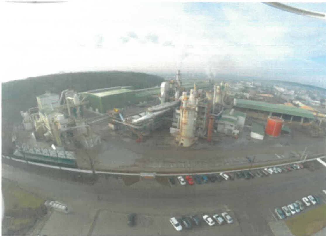
Fig. 3.3. Vedere aeriană a platformei industriale S.C. Kastamonu România S.A.
