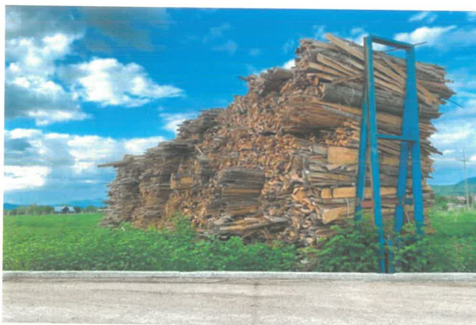
Fig. 5-5 Bariera fonică rastei lăturoaie – zona depozit materie primă spre Cartierul Câmpului
