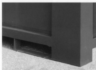
Orificii pentru manipulare cu motostivuitoare.
