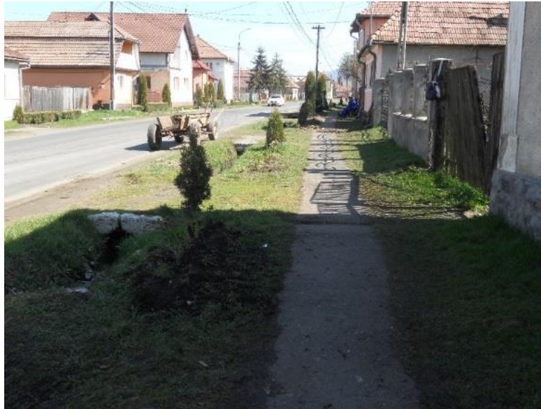
Fig.6. Strada din Gurghiu, apele pluviale sunt colectate prin rigole stradale (Foto Ildiko Mocsy -2014)
