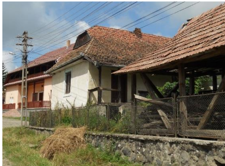
Fig.7. Anexele gospodărești sunt construite din lemn, combinate cu cărămidă, piatră, șarpantă din lemn, acoperișuri înalte cu învelitoare din țigle (Foto: Mocsy I.-2014)
