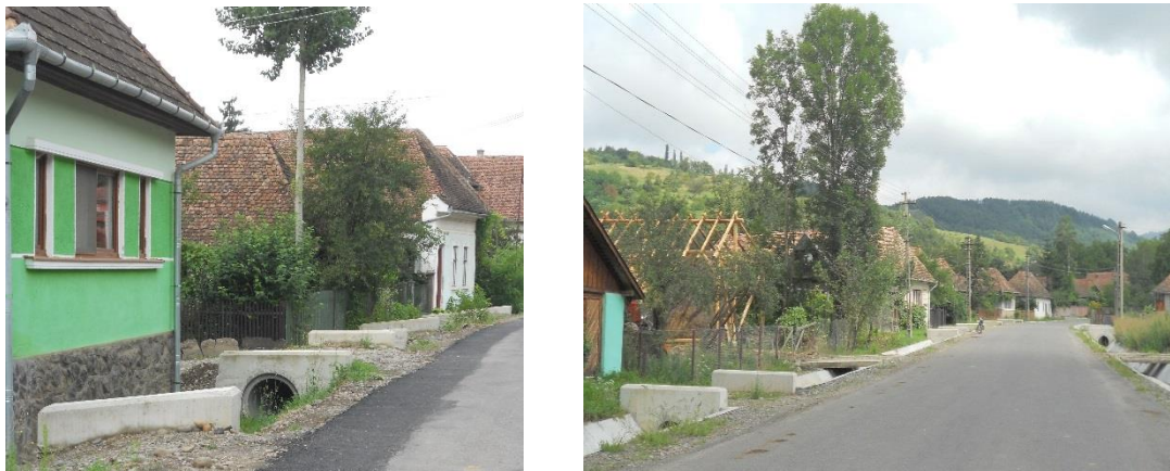
Fig.9. Strada din Măgherani și Torba, apele pluviale sunt colectate prin rigole stradale (Foto: Ildiko Mocsy -2014)
