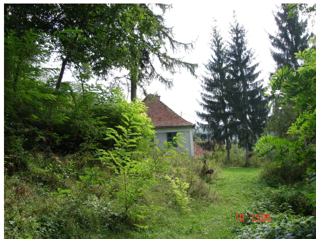
Pipea FOTO 1.2. UTR 1 Extindere.
