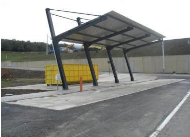
Foto 10 – DDN Sanpaul. Statia spalare-Zona de securitate
