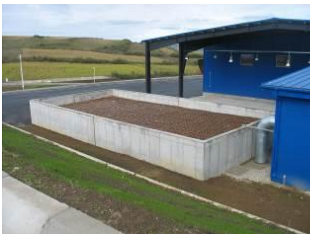
Foto 14 – TMB Sanpaul. Hala tratare mecanica - biofiltrul
