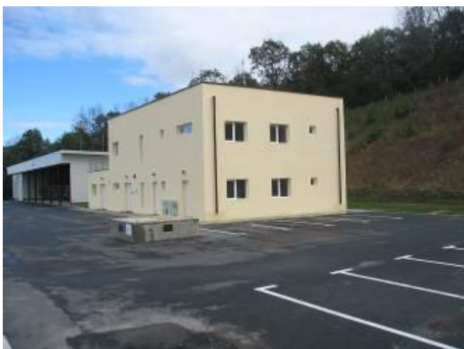
Foto 6 – DDN /TMB Sanpaul. Cladirea administrativa
