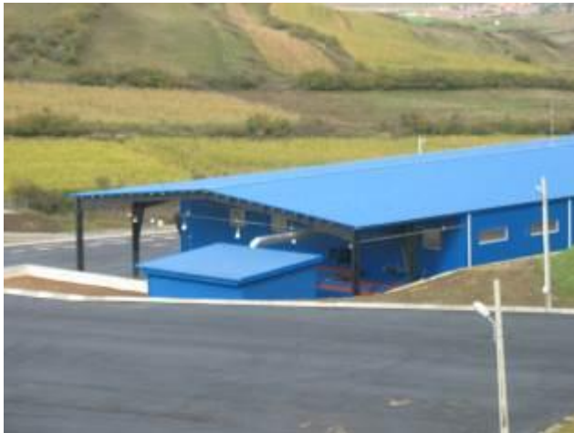
Foto 13 – TMB Sanpaul. Hala tratare mecanică (vedere către nord)
