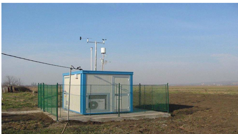
Stația de monitorizare a influenței industriale MS - 2
