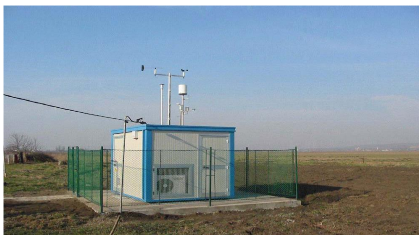
Stația de monitorizare a influenței industriale MS - 2
