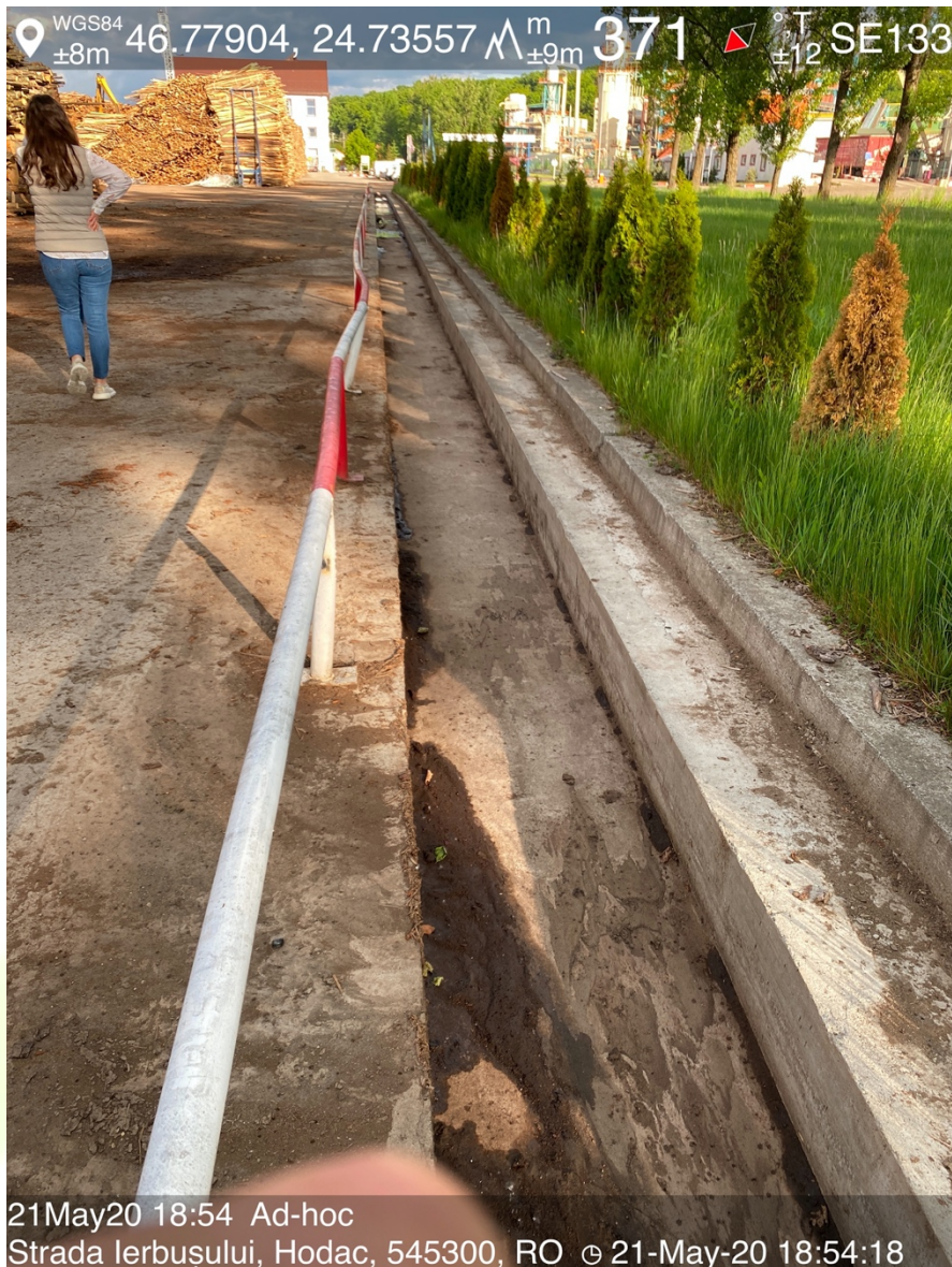
Figura nr. 54 Vedere asupra rigolei sudice de la depozitul de Materii Prime in zona Cladirii de birouri Administrativ
