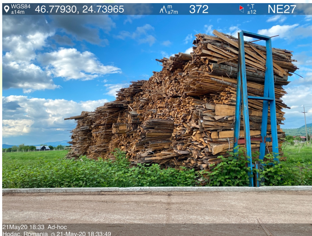
Figura nr. 52 Bariera fonica rastel cherestea calitate inferioara zona Depozit Materii Prime spre Cartier Campului
