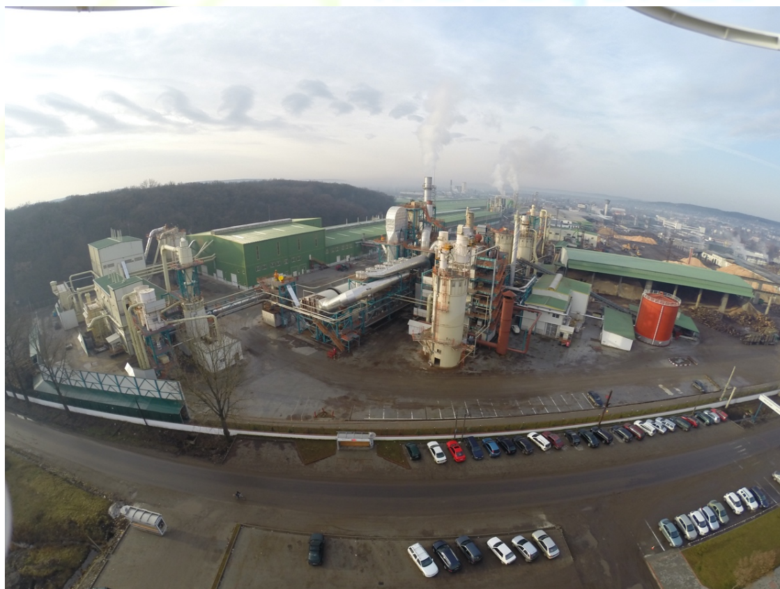
Figura nr. 2 Vedere de ansamblu din Drona asupra platformei industriale Kastamonu Romania
