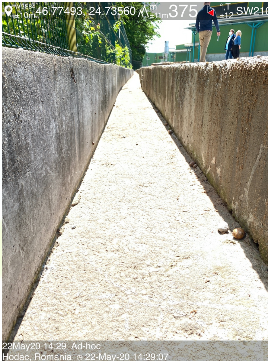
Figura nr. 53 Vedere asupra rigolei de colectare ape pluviale situata la limita amplasamentului Fabricii de PAL
