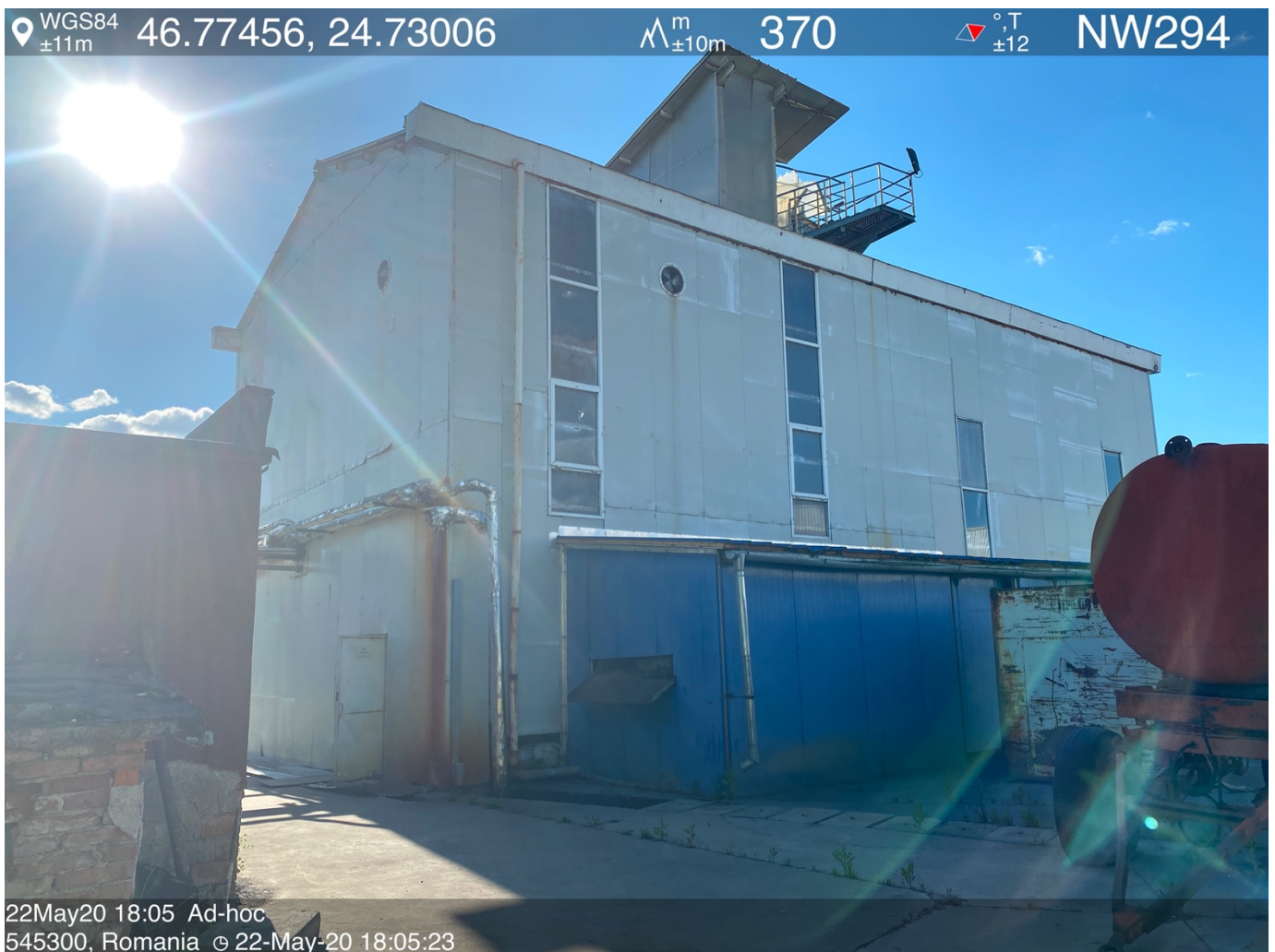
Figura nr. 41 Stafia de epurare mecano-biologica din incinta Kastamonu Romania S.A
