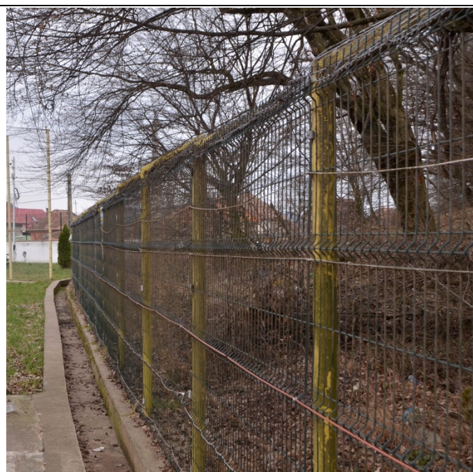
Limita estica a amplasamentului, spre Padurea Mociar – detaliu gard
