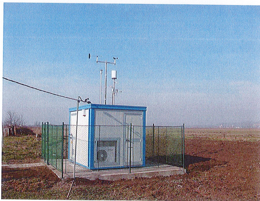
Stația de monitorizare a influenței industriale MS - 2
