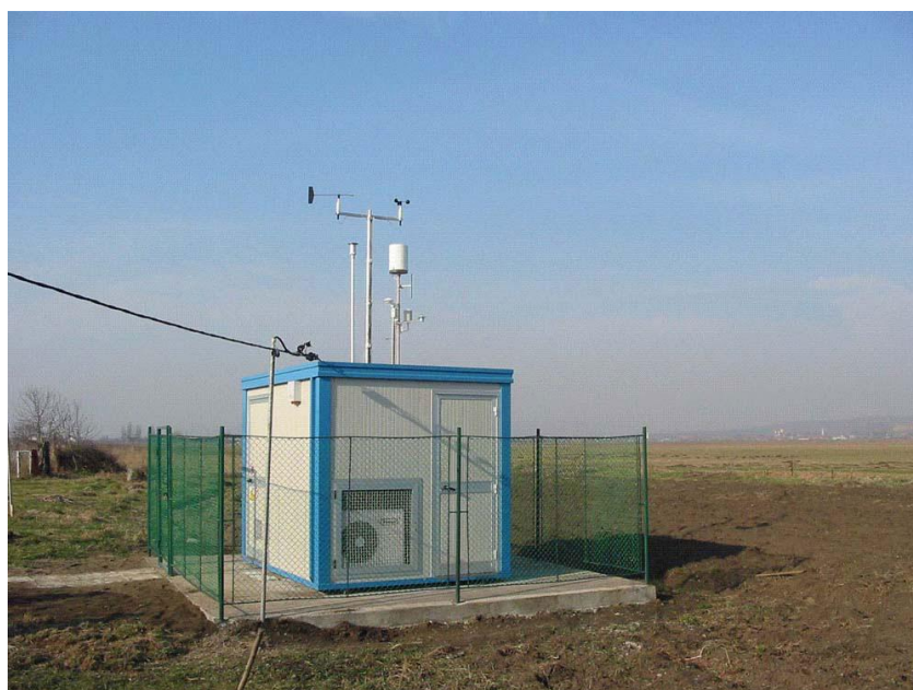
Stația de monitorizare a influenței industriale MS - 2
