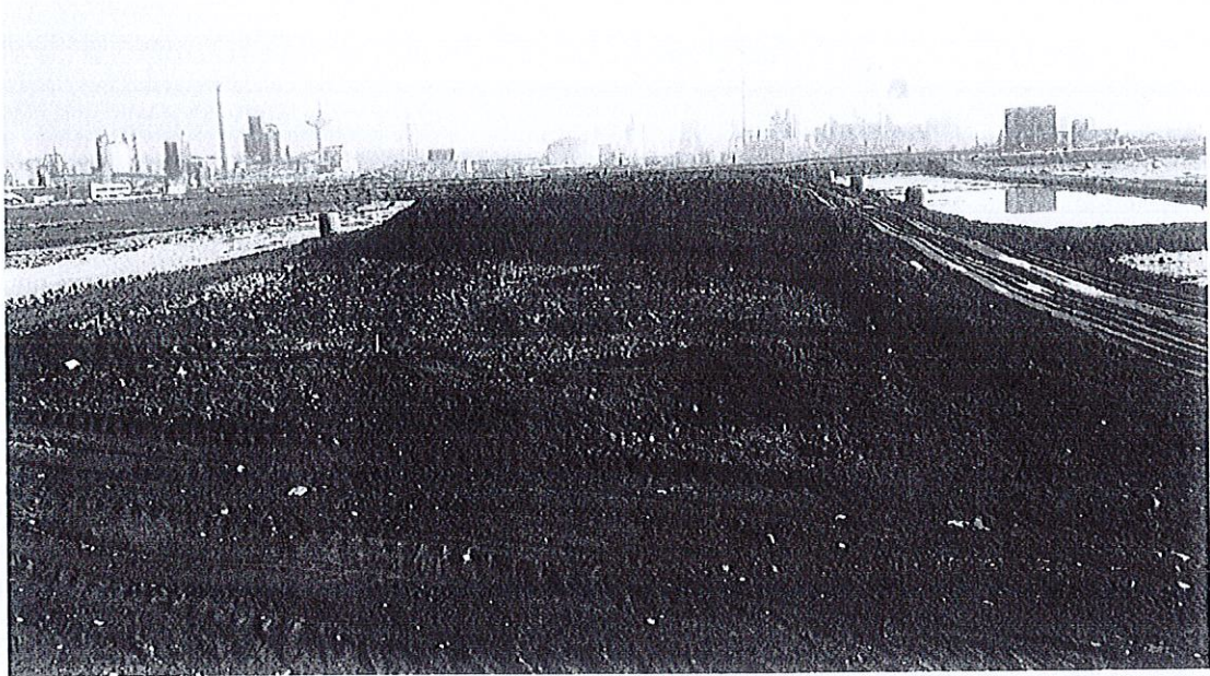
Figura 9 - Stadiul lucrărilor de umplutură în perioada 18.02.2019 – 20.02.2019
