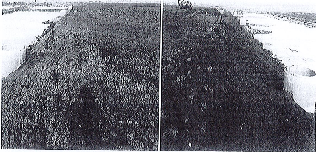
Figura 11 - Stadiul lucrărilor de umplutură în perioada 18.02.2019 – 20.02.2019
