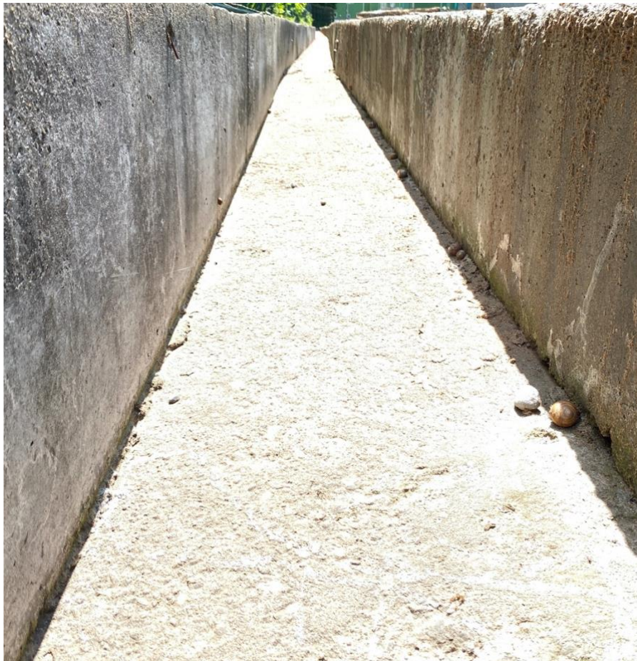
Figura nr. 11-1 Vedere asupra rigolei de colectare ape pluviale situata la limita amplasamentului Fabricii de PAL
