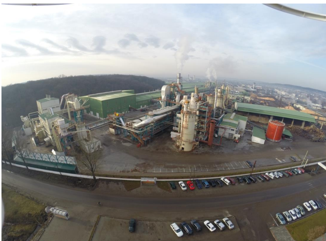
Figura nr. 3-3 Vedere de ansamblu din Drona asupra platformei industriale Kastamonu Romania
