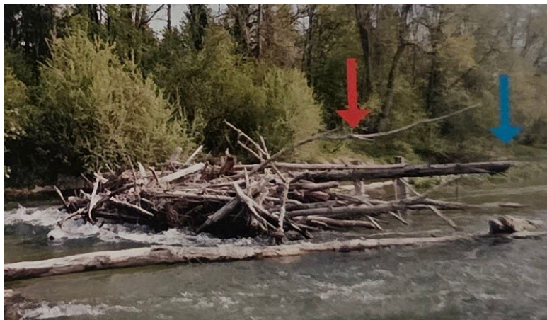
Apărări de mal din crengi moarte, fixate cu țăruși
