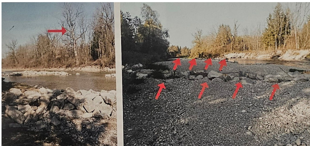
Epiuri din piatră îndreptate spre amonte
