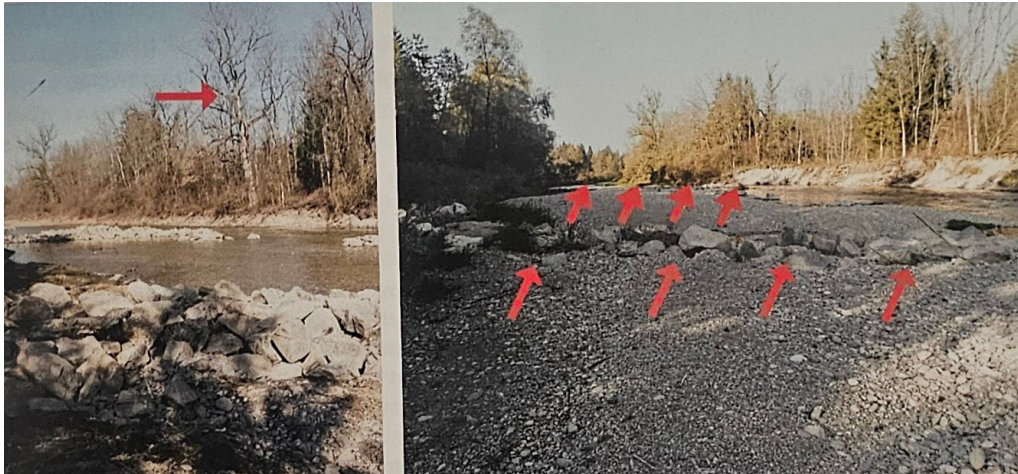
Epiuri din piatră îndreptate spre amonte
