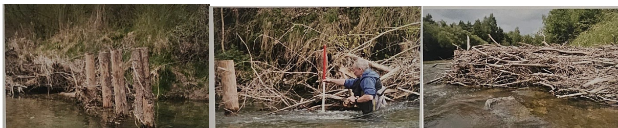
Apărări de mal din crengi moarte, fixate cu țărushi
