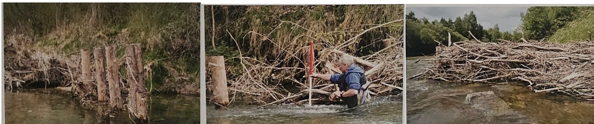
Apărări de mal din crengi moarte, fixate cu țăruși
