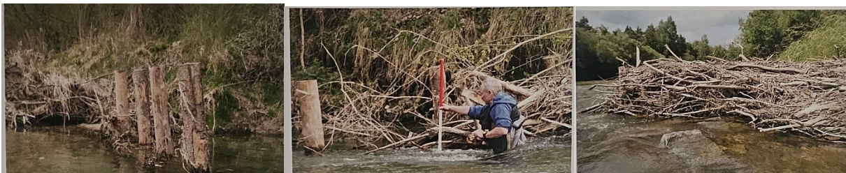
Apărări de mal din crengi moarte, fixate cu țărugi
