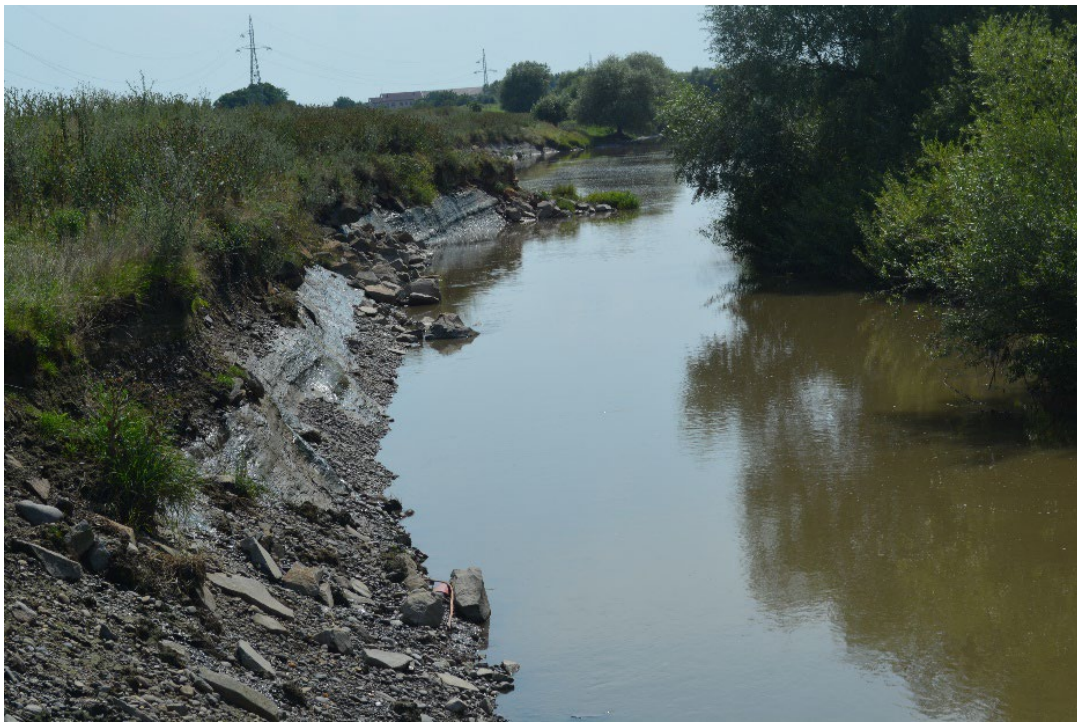
Vedere regularizare amonte de prag, se observă o puternică eroziune de mal stâng (L=100 m) și concavitate la cca. 25 m de piciorul digului de apărare
