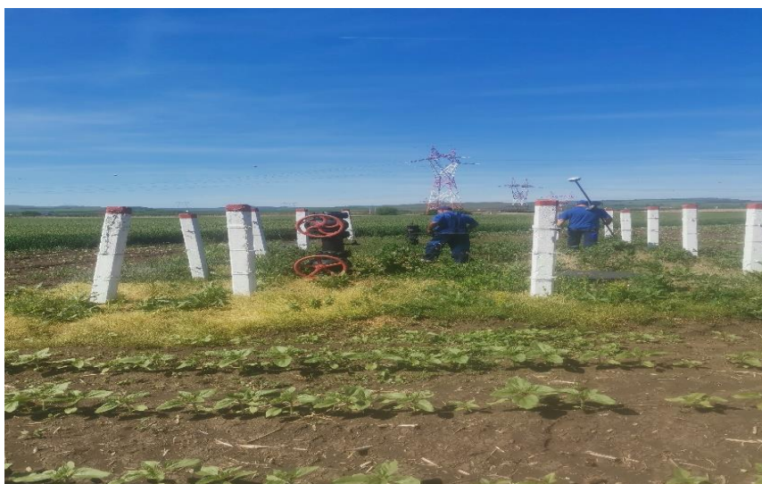
Fig. 5. Aspect amplasament punct de intervenție P5- Robinet 98 existent, km 22+259
