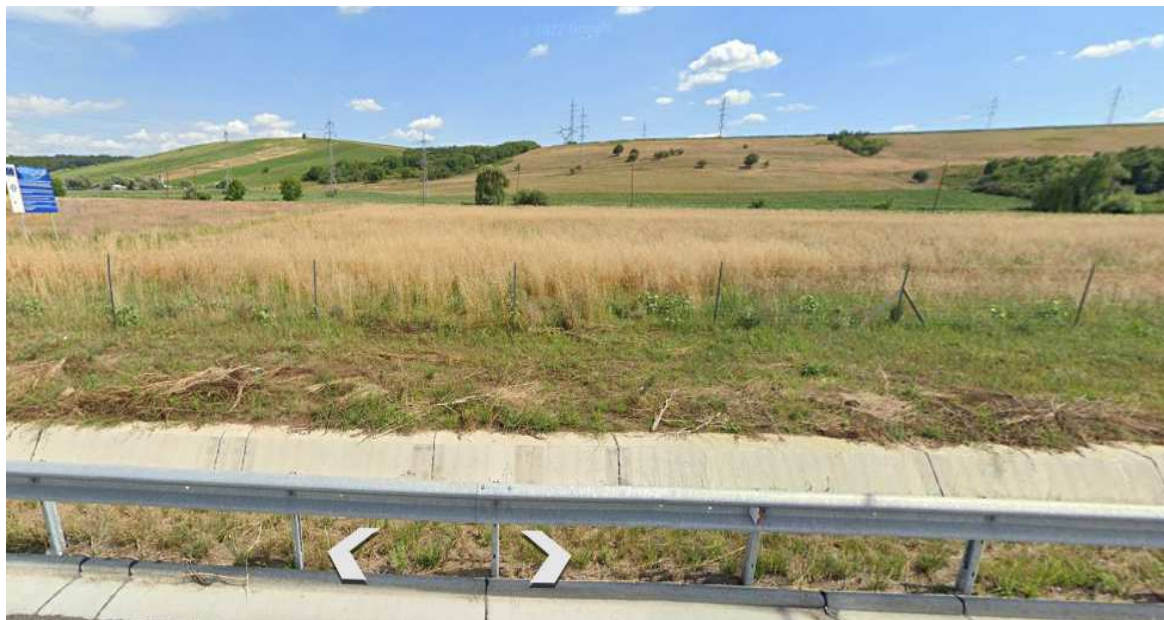
Vedere dinspre breteaua de legătură cu A3
