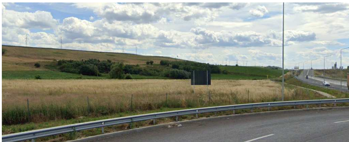
Vedere dinspre sensul giratoriu
