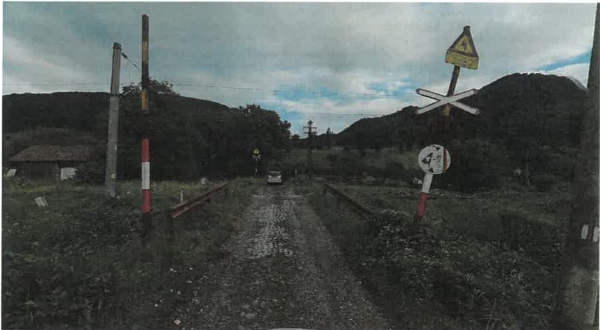
Foto 2 – Amplasamentul proiectului – Trecere la nivel si terasament cale ferata
