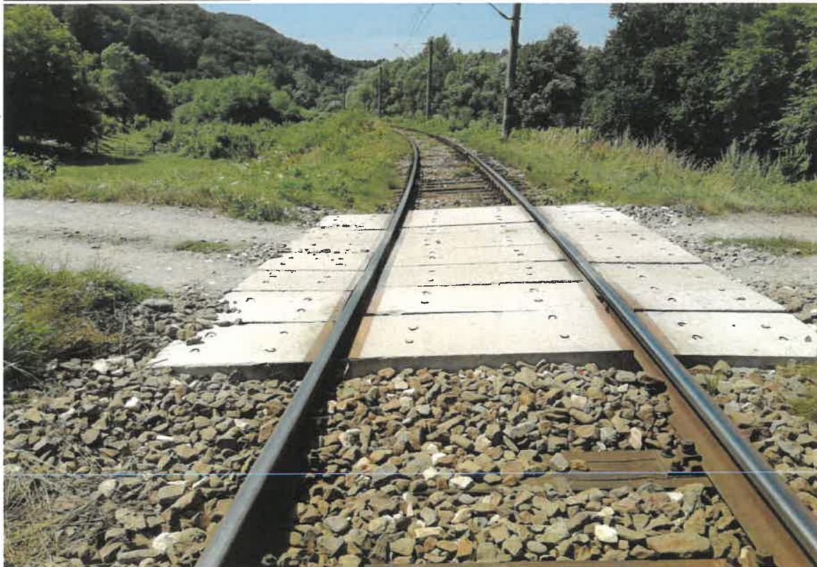
Foto 1 – Amplasamentul proiectului – Trecere la nivel si terasament cale ferata
