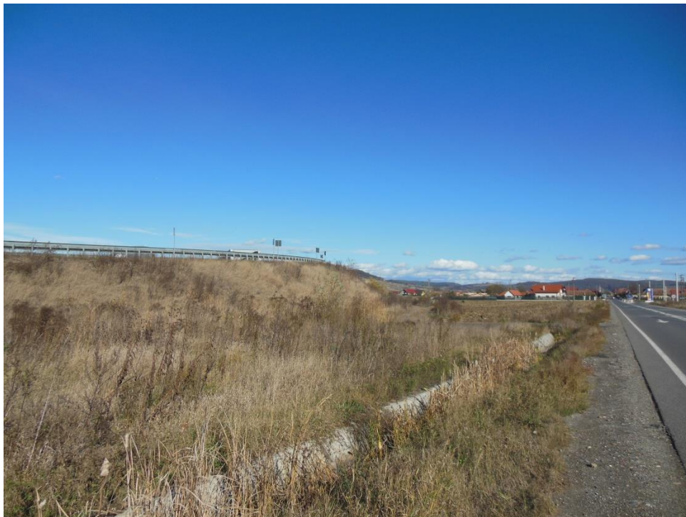
Foto 2. La sud se sectorul de DN14 care se găsește în ROSPA0099 Podișul Hârtibaciului există teren construit și teren arabil.
