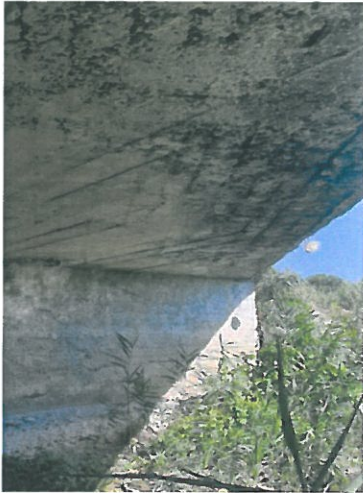
Intradosul dalei din beton armat
