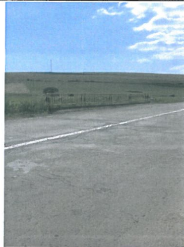
Calea de rulare de pe pod
